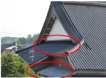
本堂西側 赤丸→工事予定
